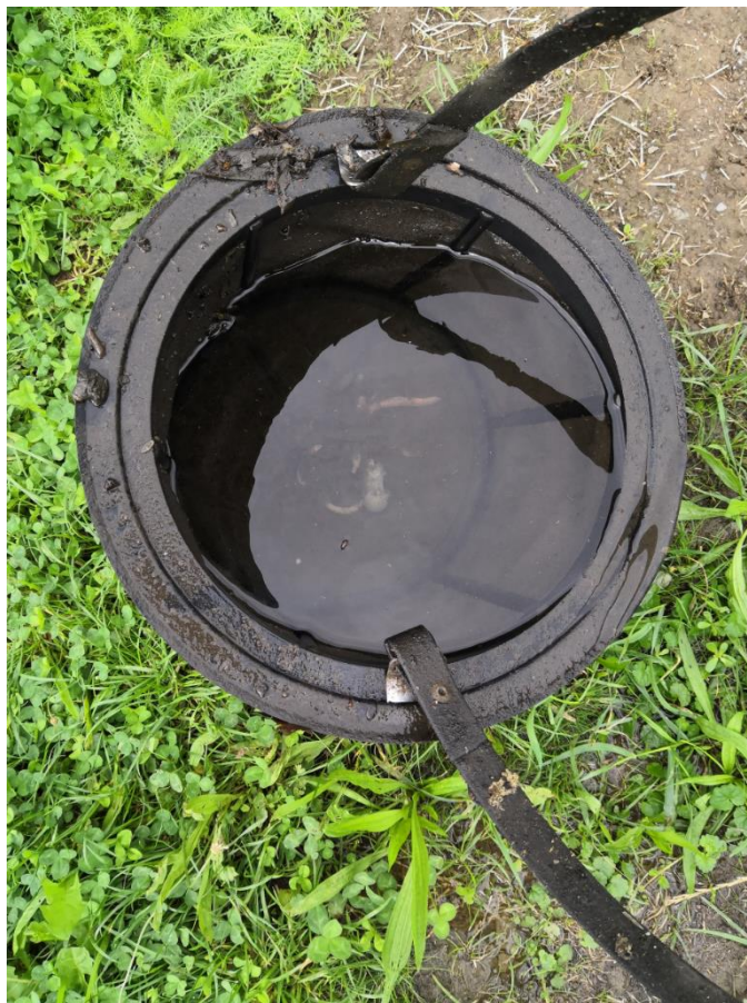
Pravidelné čištění jemného filtru je součástí údržby vodního hřiště.
