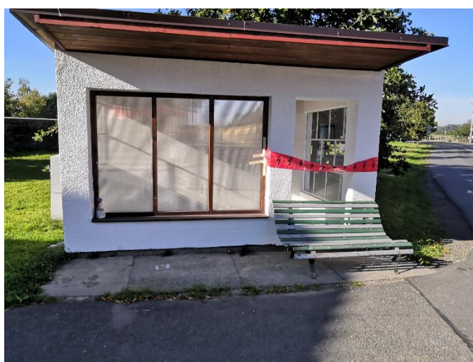
Po mnoha letech se dočkala i čekárna. Byla opravena její střecha, vsazena nová okna a provedena vnitřní i venkovní výmalba.
